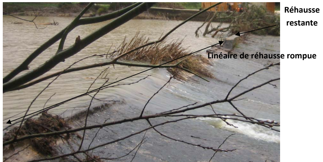
Photo 1 19-01-2014 Surverse sur le barrage de Camp Long, vue de la crête du barrage depuis la rive droite
