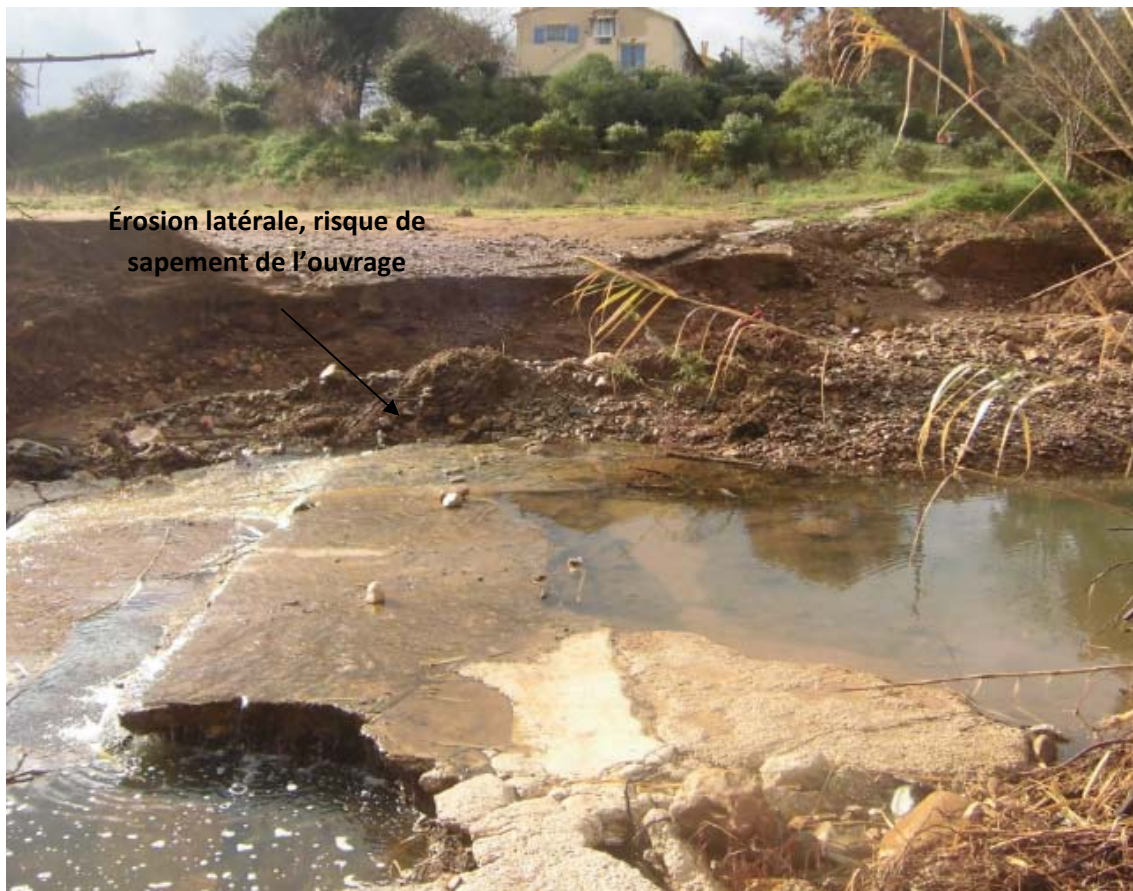
Figure 23 Photographie du seuil en aval du domaine des Jassons
