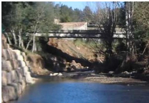
Photo 9 Pont de la RD 559 vu de l'aval.
