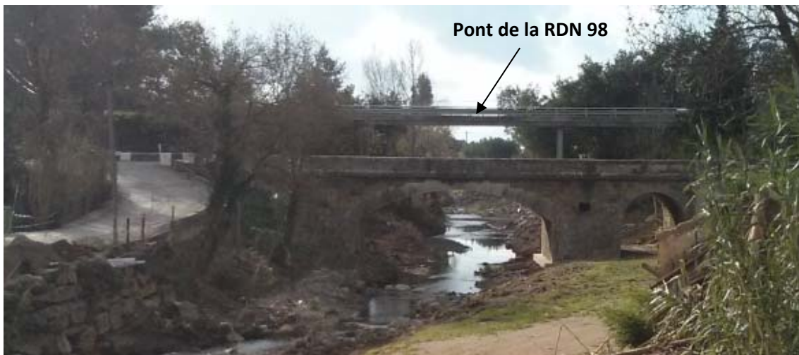
Photo 8 Pont en amont de la RDN 98, vu de l'amont
