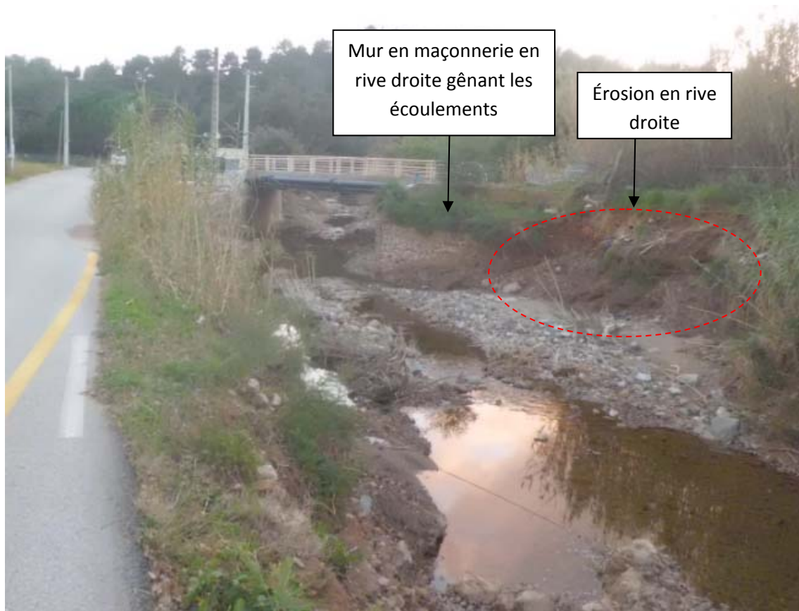
Photo 5 Pont en aval de Notre Dame des Maures
