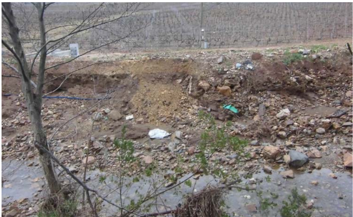
Photo 3 29-01-2015 Digues en rive gauche du Pansard
