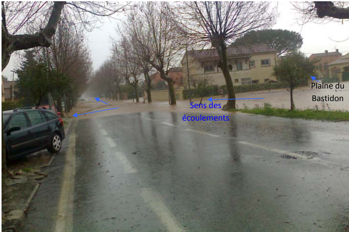
Photo 13 Boulevard Louis Bernard pendant la crue de janvier 2014 (du nord vers le sud, à proximité du pont Blanc)
