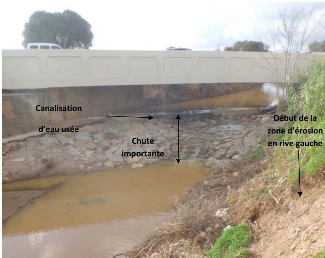
Figure 16 Pont Blanc vu de l'aval
