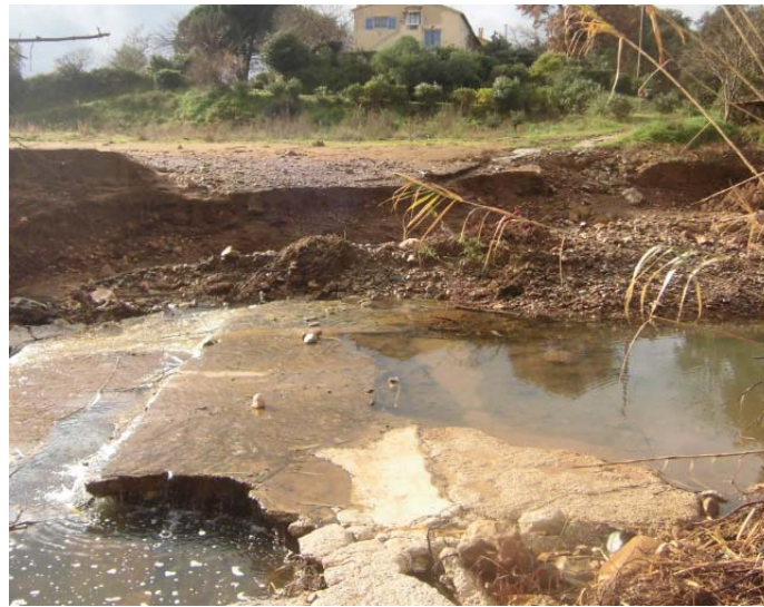
Photo 6 Photographie du seuil en aval du domaine des Jassons
